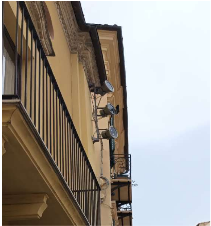
Proiettori esistenti posti diagonalmente alla facciata della chiesa
