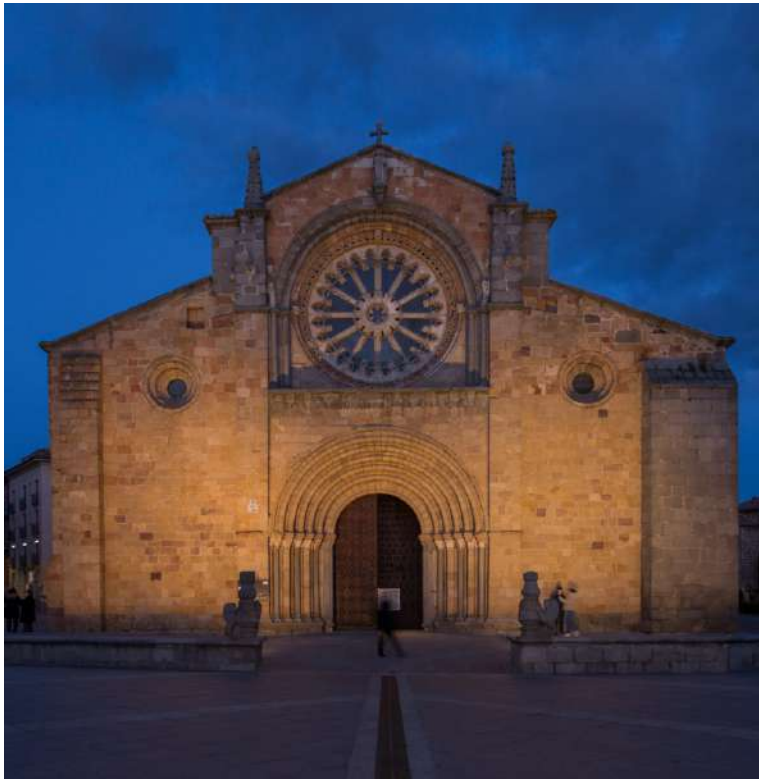
Rif. 1 - Illuminazione della facciata
